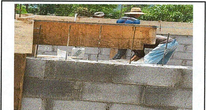
Foto 2: Fundición de soleras.
