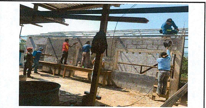
Foto 5: Colocación de costaneras.
