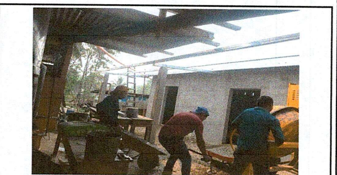
Foto 6: Colocación de lámina.
